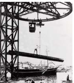
昭和初期、国鉄清水港線清水港駅に木材積み込み用に建設された「テルファ」。日本に唯一残る産業遺産として、エスバルスドリームプラザ前にある(写真提供/フェルケール博物館)
